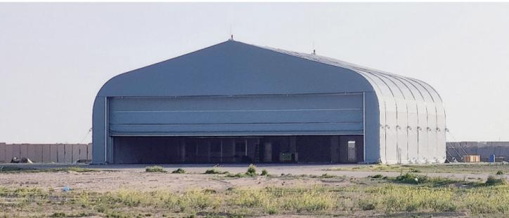
用铝基构件，重量轻，具有方便运输、快速部署、防雨抗风、美观实用等特点，可满足快速反应、高机动性、高隐蔽性及其他领域不同场景的需求。产品规模可针对不同客户、不同装备进行定制，目前规划总院已成功实施多个案例。
