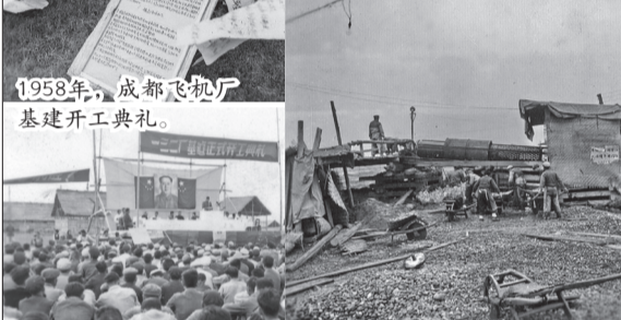
成都飞机厂的基建工地。
