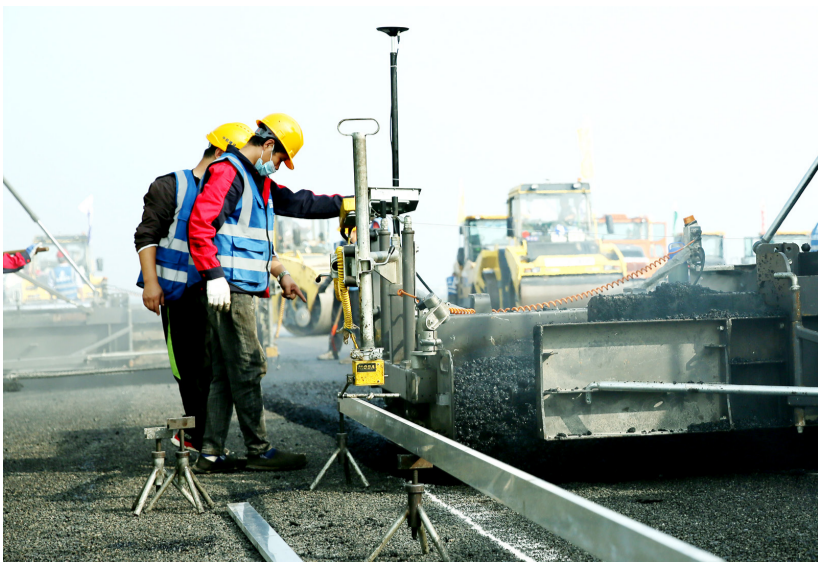
参与北京首都国际机场跑道大修工程建设
